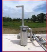
Filtri biologici e scambiatori per la rimozione di composti dello zolfo, particolato e condense
