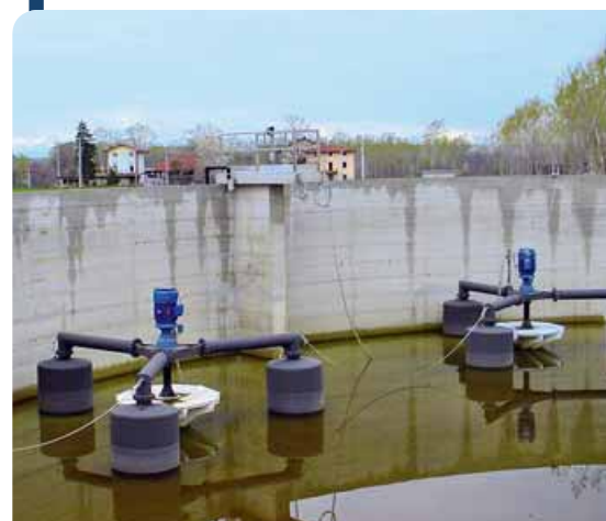
Foto 2 - A un'analisi benefici/costi gli ossigenatori di superficie risultano il sistema più interessante per il trattamento dei liquami zootecnici
